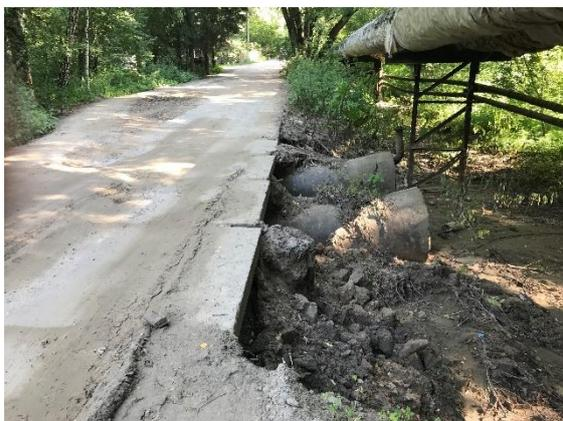
Фото 2. Размытая горячей водой дорога – результат испытания теплотрассы повышенным давлением
